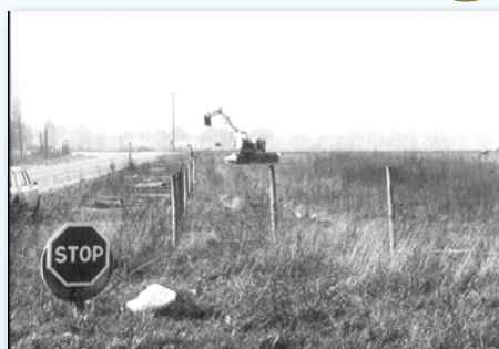
Photographie du site de Saint-Quentin-en-Yvelines avant travaux
